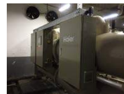
PH1導入400RT磁懸浮冰水主機
