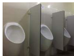
廠區更換免沖水小便器
