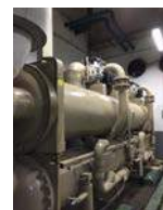
PH1導入400RT磁懸浮冰水主機
